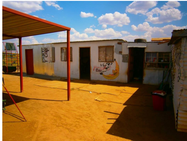
L'extension d'une nouvelle salle de classe a été construite
