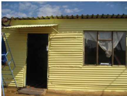
Nouvelle couche de peinture
