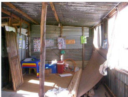
Travaux en cours
